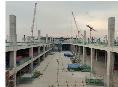
写真 21 ダッカ国際空港・新国際ターミナル（建設中）
