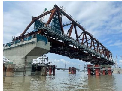
写真 19 ジャムナ鉄道専用橋（建設中）と奥に見える既設のジャムナ多目的橋
