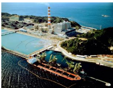
写真 1 電源開発松島石炭火力発電所 50万キロワット x 2基 長崎県西彼杵郡大瀬戸町
