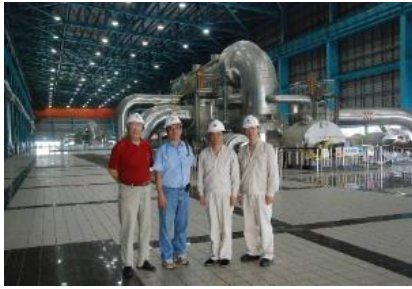
写真 5 中国上海外高橋超超臨 界圧石炭火力発電所 1000MW x2 基
