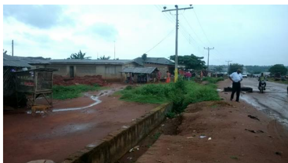
地方部幹線道路沿いの写真：電線が通っているものの停電は日常茶飯事 未舗装の道路は起伏が激しく、雨になると通れなくなる箇所も多い
