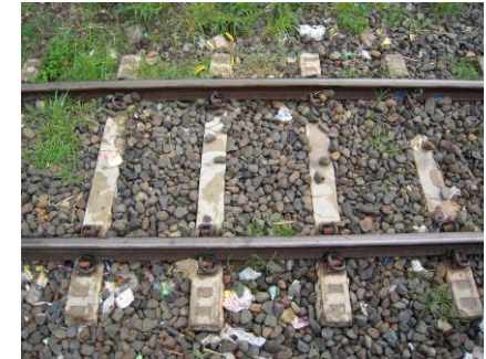
敷設済みのコンクリート枕木。木製枕木も含め、レールを固定するための金具と犬釘は、盗難にあうことが多い。
